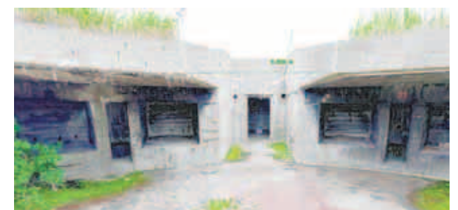
Ein „Punktwolken“-Foto des Flakbunkers, das mit dem 3D-Laserscanner zur Vermessung gemacht wurde. Foto: ein
